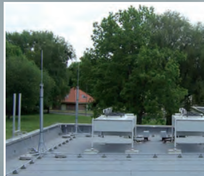
Systém DEHNconductor - vodič HVI® light
