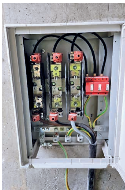
Pohled na SPD instalované v neměřené části sítě
