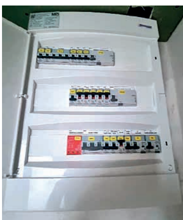
Foto bytových rozvodnic během výroby a instalace
