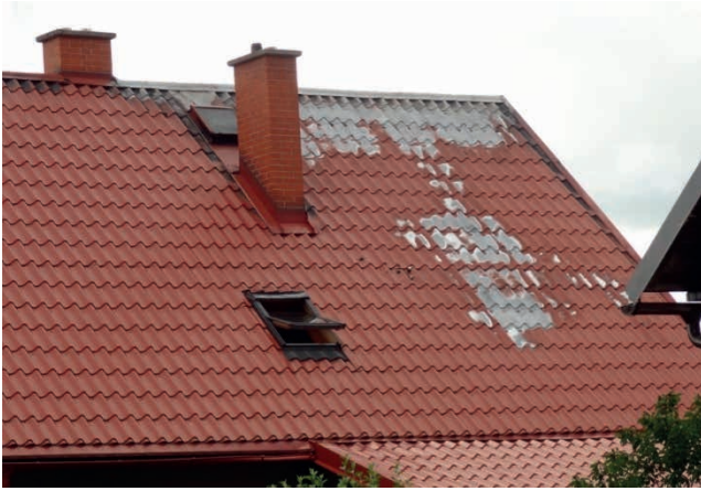
Foto: Požár po úderu blesku do kovové střechy
