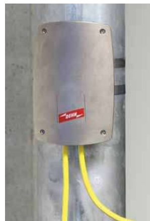
DEHNpatch CLE IP66 pro instalaci bez rozváděče
