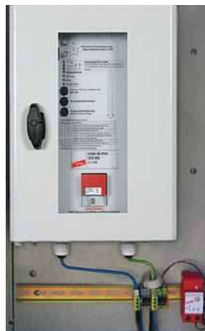
VCSD: Voltage Controlled Smart Decoupling Device pro propojení zemničů
