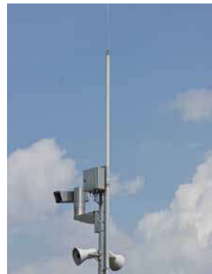
Izolovaný LPS za pomoci vodiče HVI
