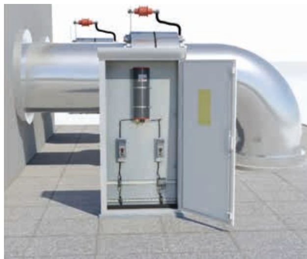
Obrázek 6 Kombinace oddělovacího jiskřiště a omezovače
