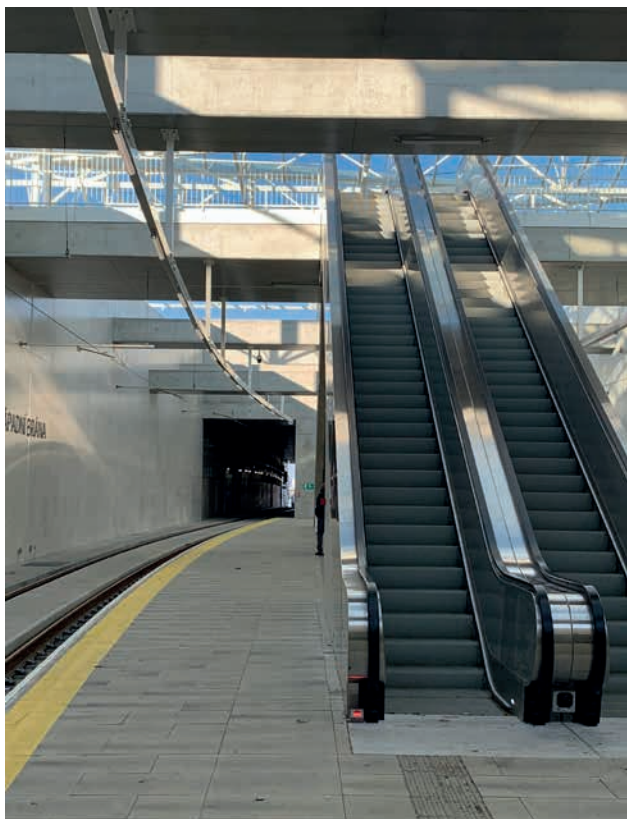
Obr. 2. Západní brána – tunel směr stanice Nemocnice Bohunice
