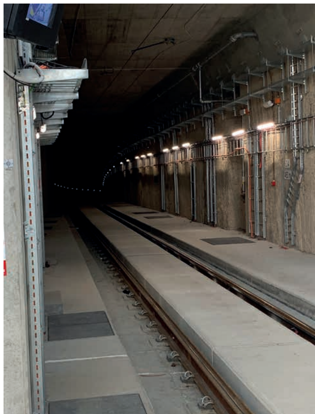
Obr. 3. Západní brána – vjezd do hloubeného tunelu
