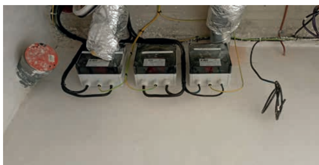
Obr. 9. Osazené rozvodnice pro technologická zařízení na střeše
