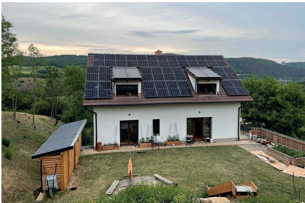
Obr. 1. Fotografie objektu s nevhovující jímací soustavou
