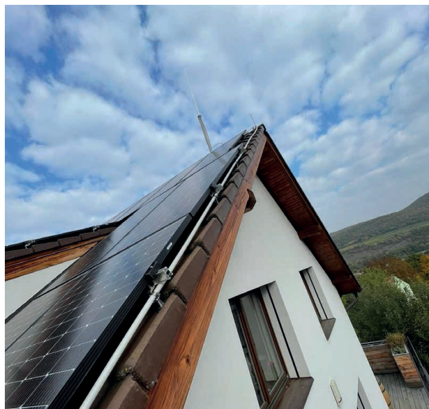
Obr. 6. Provedení svodu vodičem HVI long v blízkosti FVE
