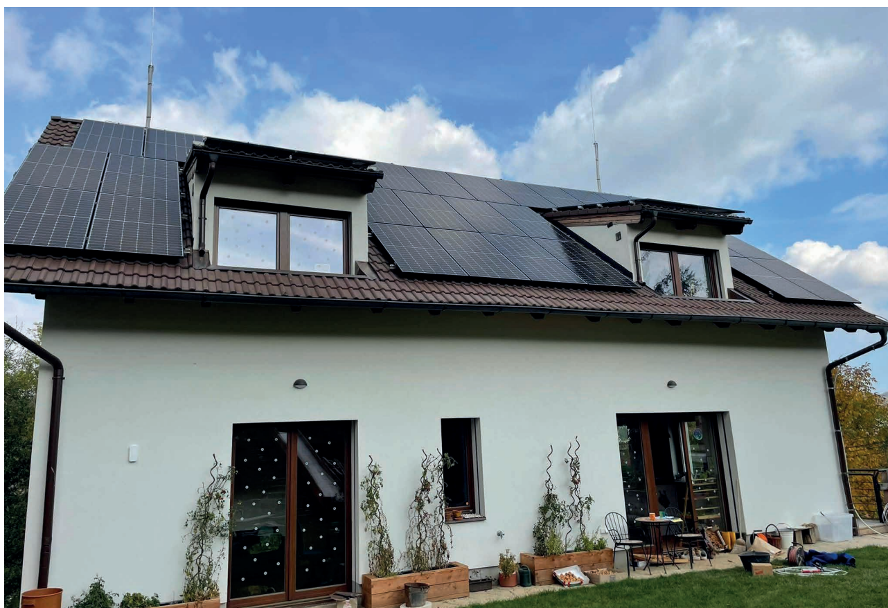
Obr. 6. Fotografie objektu s novou izolovanou jímací soustavou dle souboru norem ČSN EN 62305-1 až 4, ed. 2.
