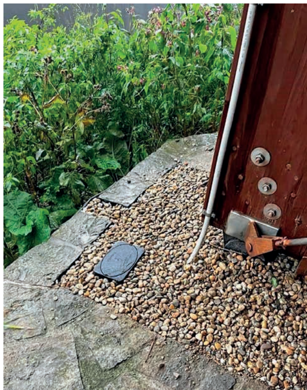
Obr. 6. Svod HVI vodičem do zemní litinové krabice
