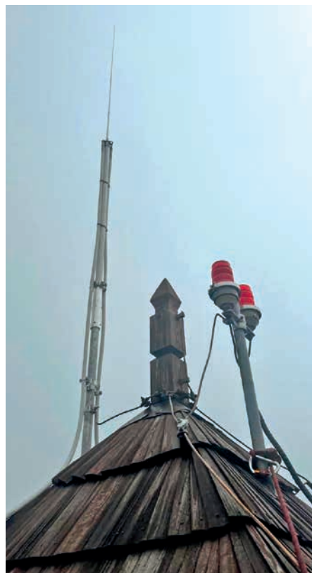
Obr. 4. Osazení podpůrné trubky s jmač tyčí na střeše objektu
