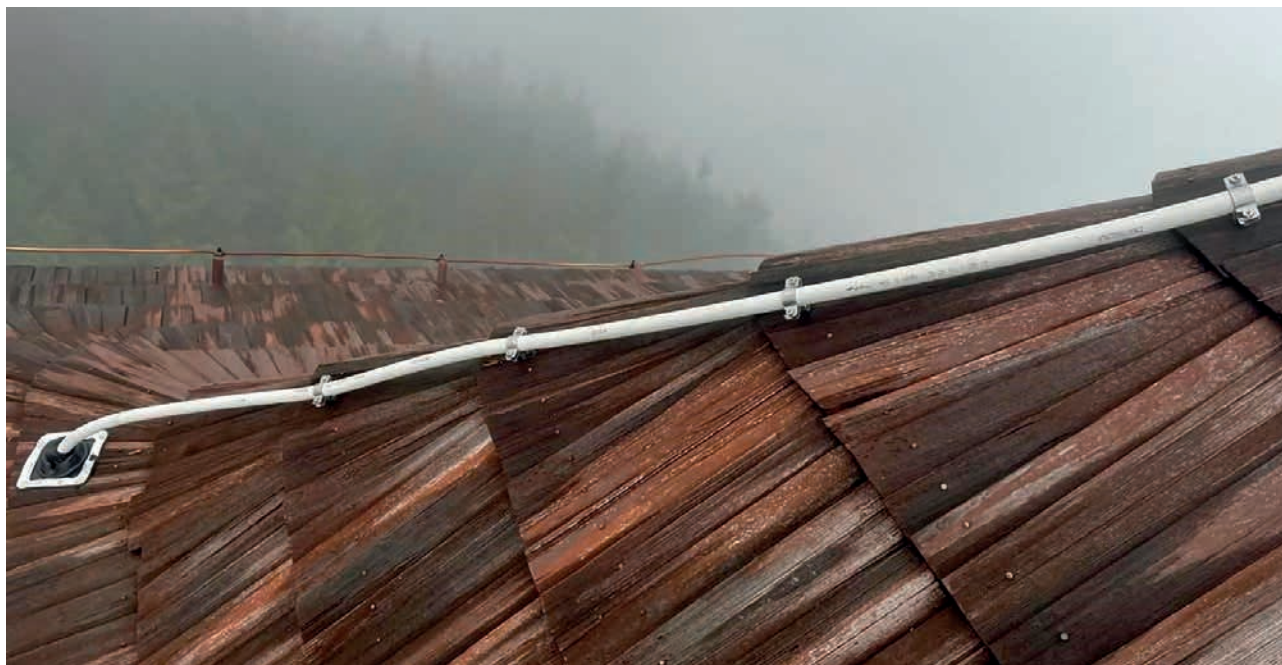
Obr. 5. Provedení svodu vodičem HVI long
