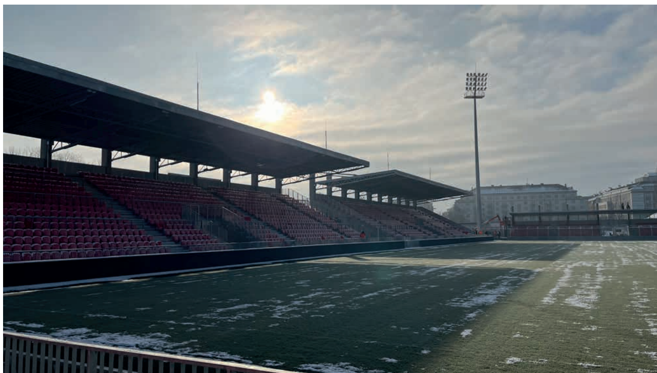
Obr. 5. Pohled na stadion a jímací soustavu
