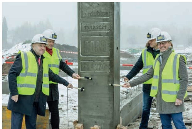
Obr. 1. Zapuštění sloupu do připraveného kalichu
