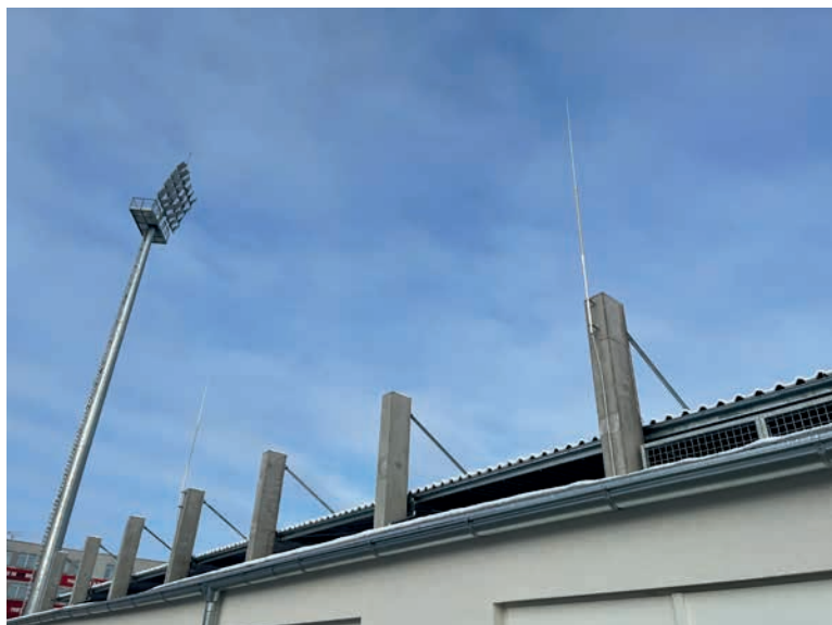
Obr. 7. Podpůrné trubky kotvené na sloupech
