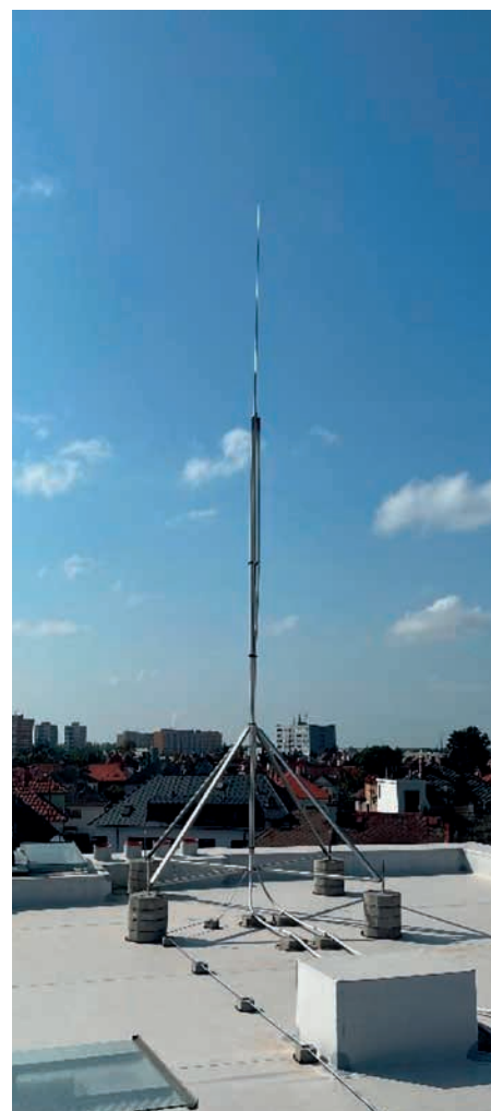
Obr. 2. Provedení podpůrné trubky s jímací tyčí
