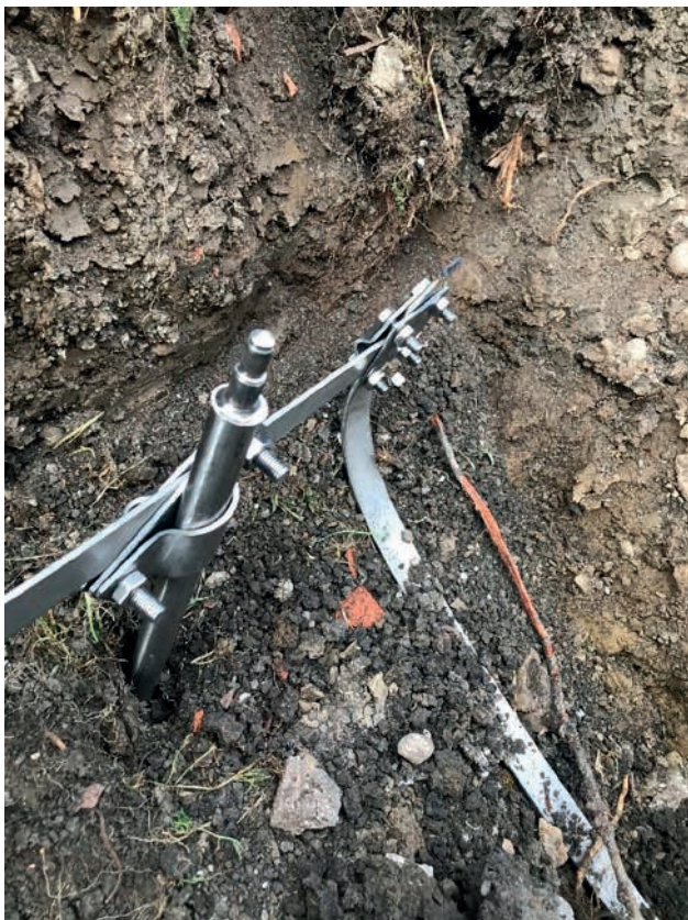
Obr. 8. Ukázka provedení zemnění
