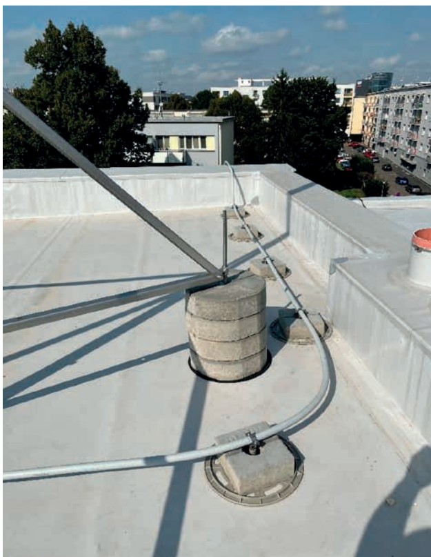
Obr. 5. Vedení HVI kotvené na ploché střeše
