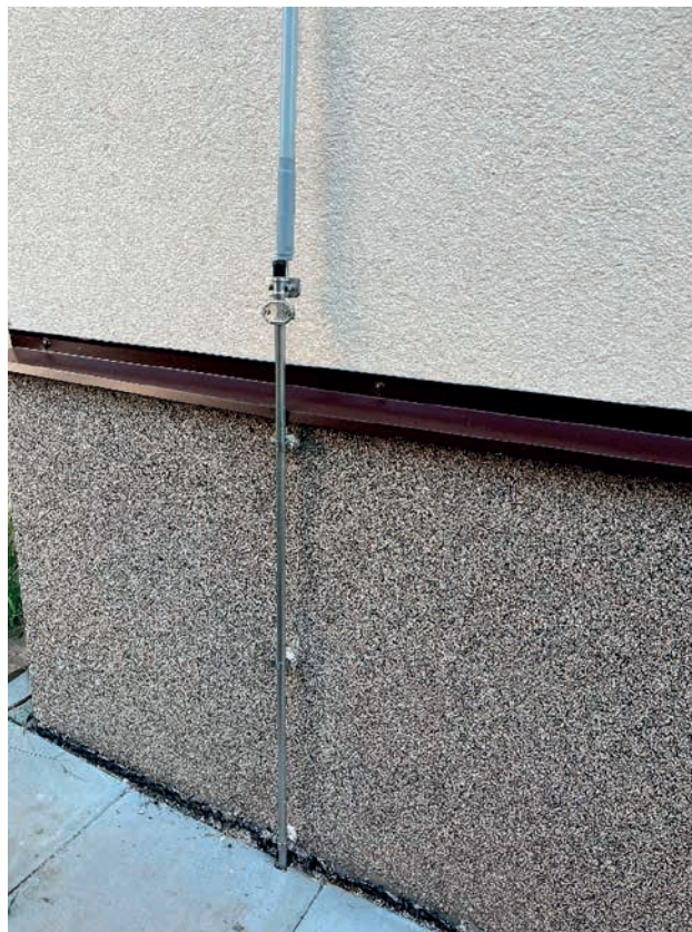
Obr. 9. Ukázka provedení zaváděcí tyče
